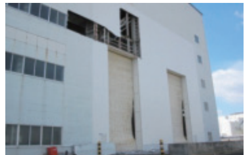
サイクル研（実規模開発試験建屋の外壁）
